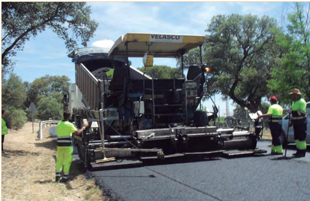
Extendido de una mezcla fabricada a baja temperatura.
