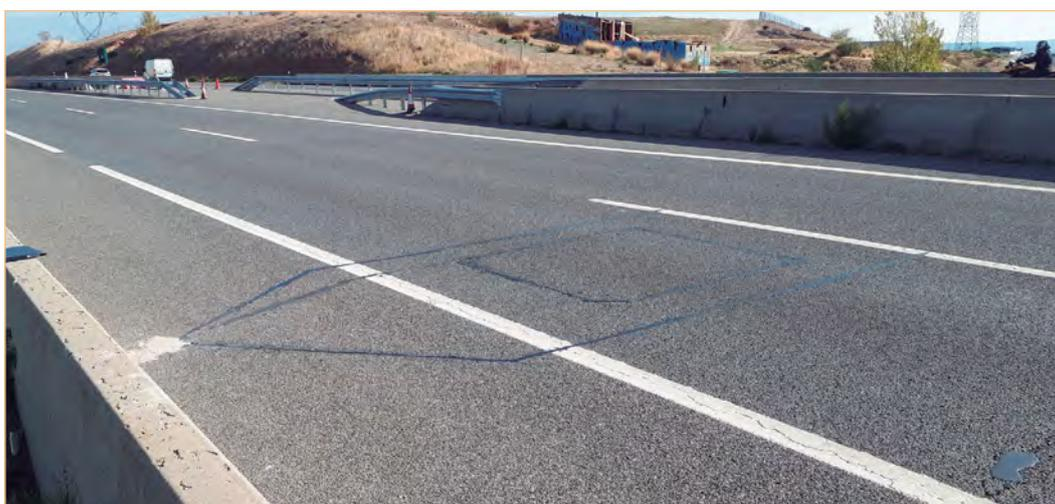
Sistema de pesaje dinámico de tipo piezoeléctrico en la A-1 en El Molar.
