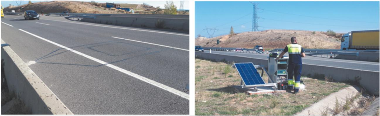
Figura 2. Aspecto de los sensores de peso y el lazo de inducción instalados en la calzada. Técnico de la empresa instaladora verificando los equipos electrónicos alojados en un armario de intemperie, al lado del panel solar para suministro de energía eléctrica.
