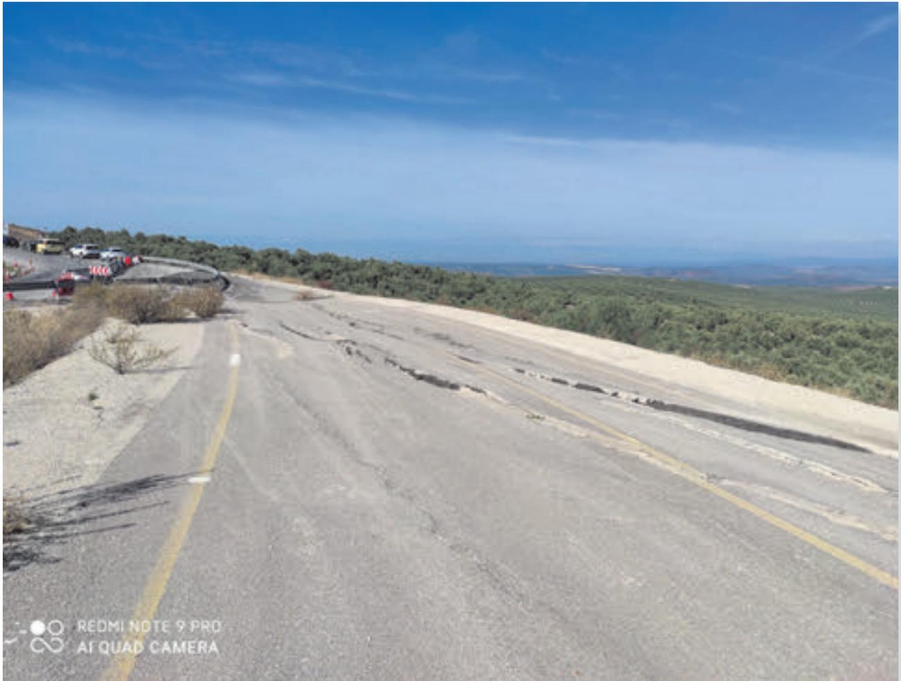
**Figura 2.** Estudios de patologías geotécnicas en carreteras. Enlace de Canena (Jaén).
