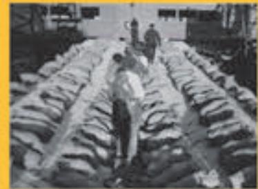
Detalle de la armadura de la cubierta del Hipódromo de la Zarzuela y fotografía de la prueba de carga de la estructura. ETM-117.
