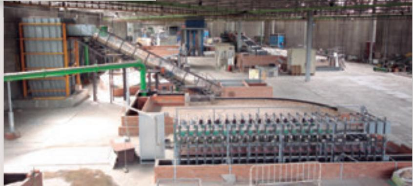
La Nave I del Laboratorio de Hidráulica, diseñada por Miguel Fisac, está formada por unas vigas de hormigón de 22 m de luz con una característica forma de hueso que garantizan una iluminación natural de gran uniformidad y que tienen un especial valor arquitectónico. La Nave II, diseñada por José Antonio Torroja, consta de una cubierta con estructura metálica reticulada de gran amplitud y en ella se ubican los modelos de mayores dimensiones.
