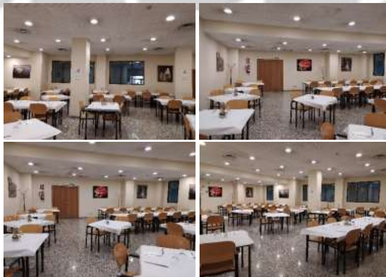
Nuevos dispositivos LED instalados en el comedor del CETA
