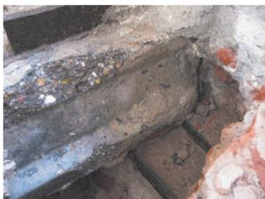
Calas en forjado del edificio para caracterización de los nervios.
