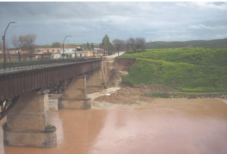
Descalce de Puente de Hierro sobre el río Guadalimar (Jaén). Fotografía facilitada por la Unidad de Carreteras del Estado en Jaén.
