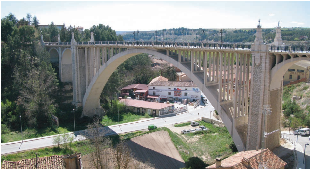
Figura 4. Inspección de puentes históricos. Puente de Fernando Hué en Teruel.
