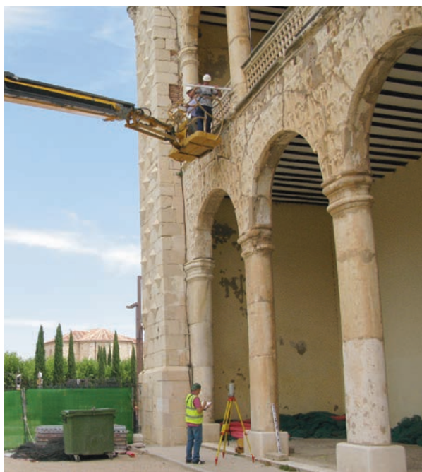
Figura 3. Inspección de la Galería de Poniente del Palacio del Infantado (Guadalajara).
