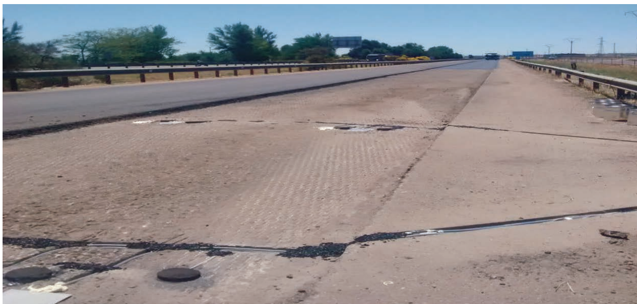
Figura 3. Sensores de deformación en firmes semirrígidos.
