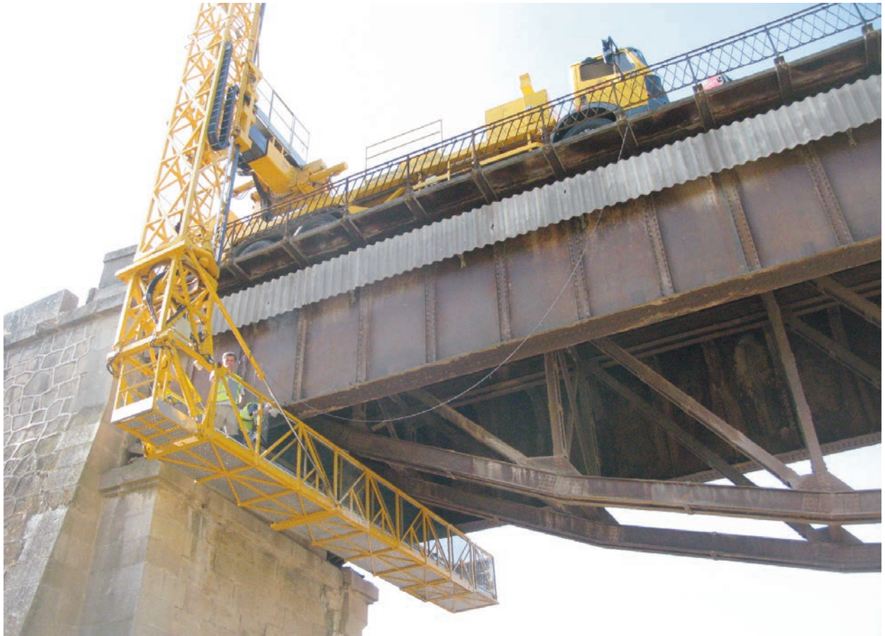
Figura 1. Inspección de puentes mediante pasarela autoportante.
