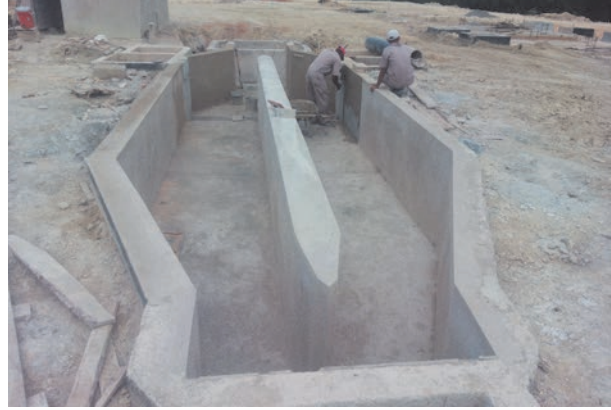
Figura 10. Obras de construcción de la planta de tratamiento de aguas residuales de Mantilla (La Habana, Cuba).
