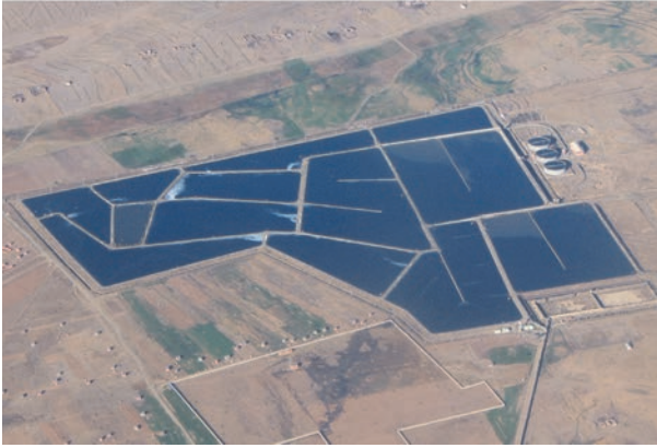
Figura 9. Planta de tratamiento de aguas residuales de Puchukollo (El Alto, La Paz, Bolivia).
