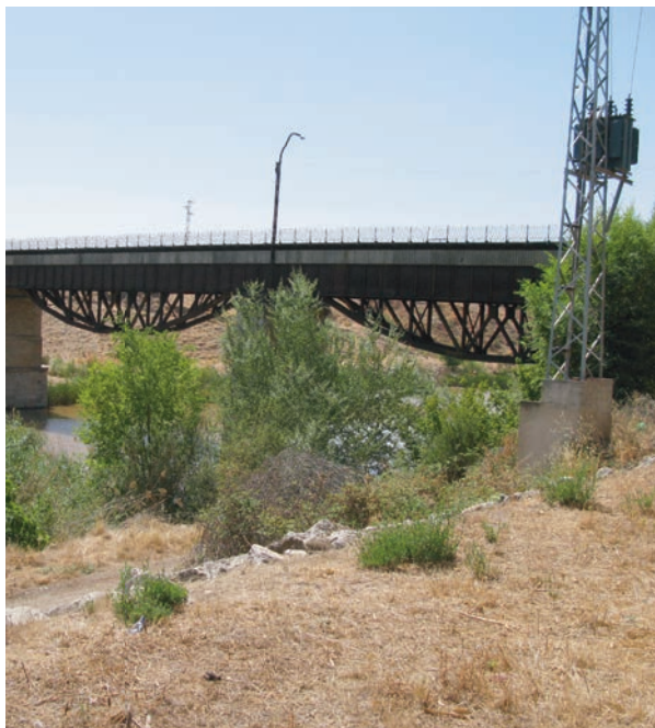
Figura 2. Inspección del "Puente de Hierro" en Estación Linares-Baeza (Jaén).
