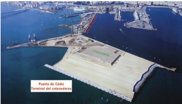
Figura 7. Terminal de contenedores del Puerto de Cádiz: relleno con su última precarga zonificada y obras del vial de acceso desde el núcleo urbano.
