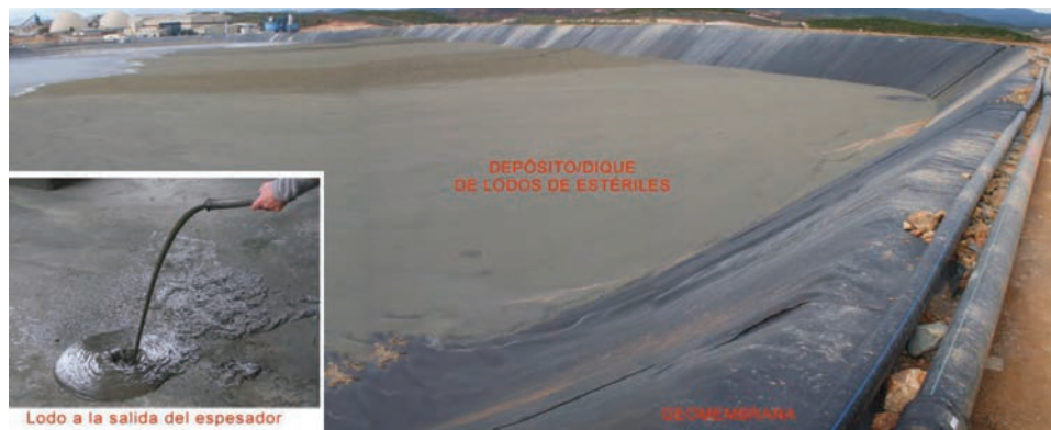
Figura 13. Mina de Aguas Teñidas (Huelva); vista general del depósito de estériles, previo a la fase final de recrecido de 14 m y sellado.
