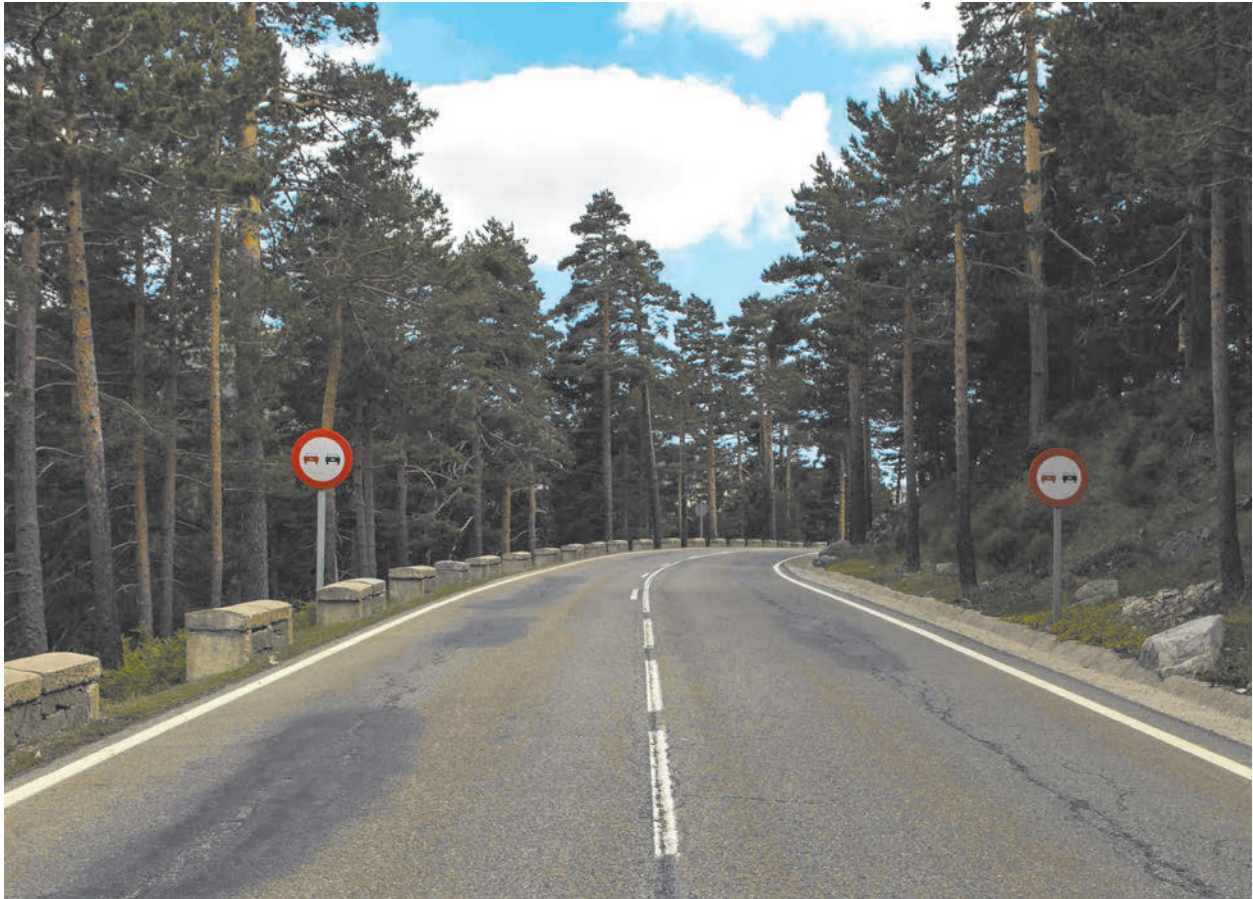
Figura 1. Carretera de montaña.
