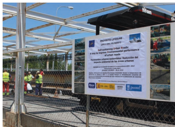
Figura 4. Evaluación del comportamiento de un firme construido con mezclas bituminosas templadas y recicladas en la pista de ensayo acelerado de firmes del CEDEX.
