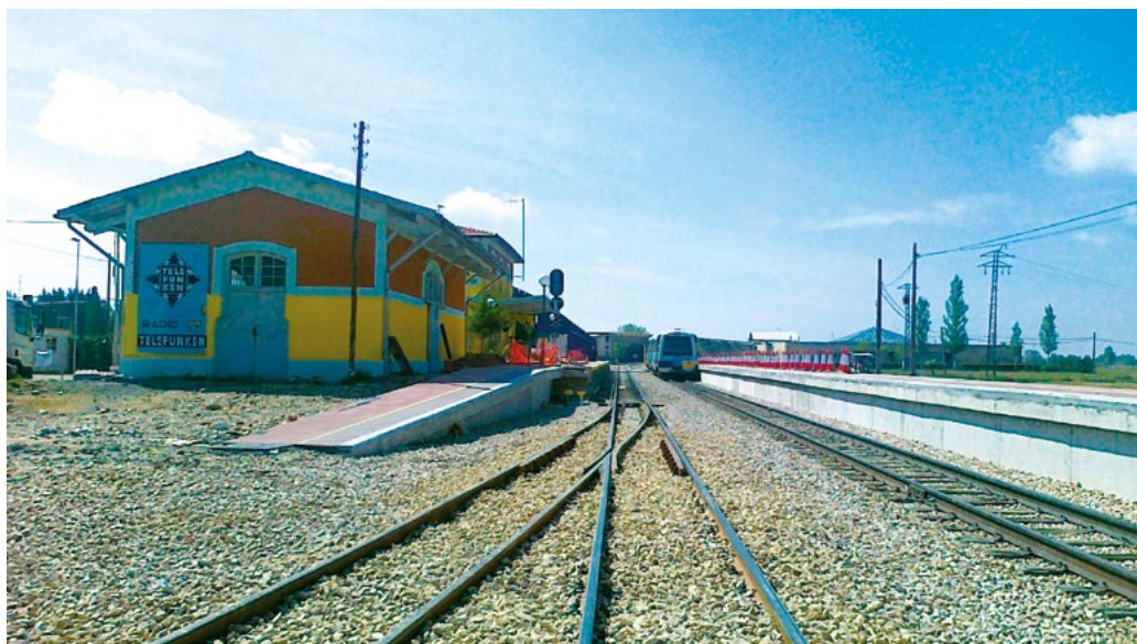
Figura 4. El ERTMS deberá desplegarse en las líneas regionales.
