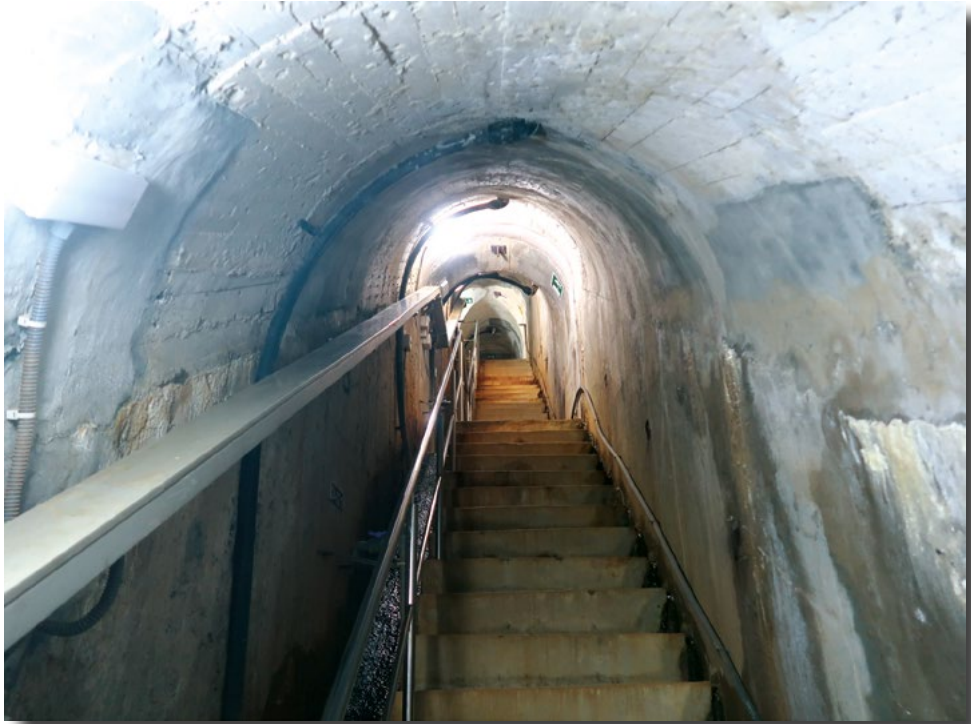
Galería de la presa.
