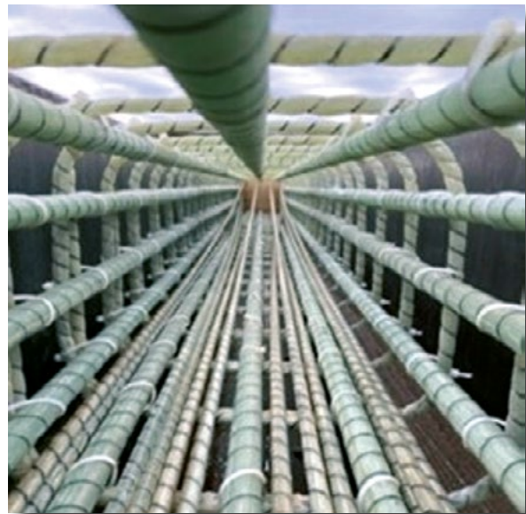
Armaduras de acero galvanizado y GFRP.
