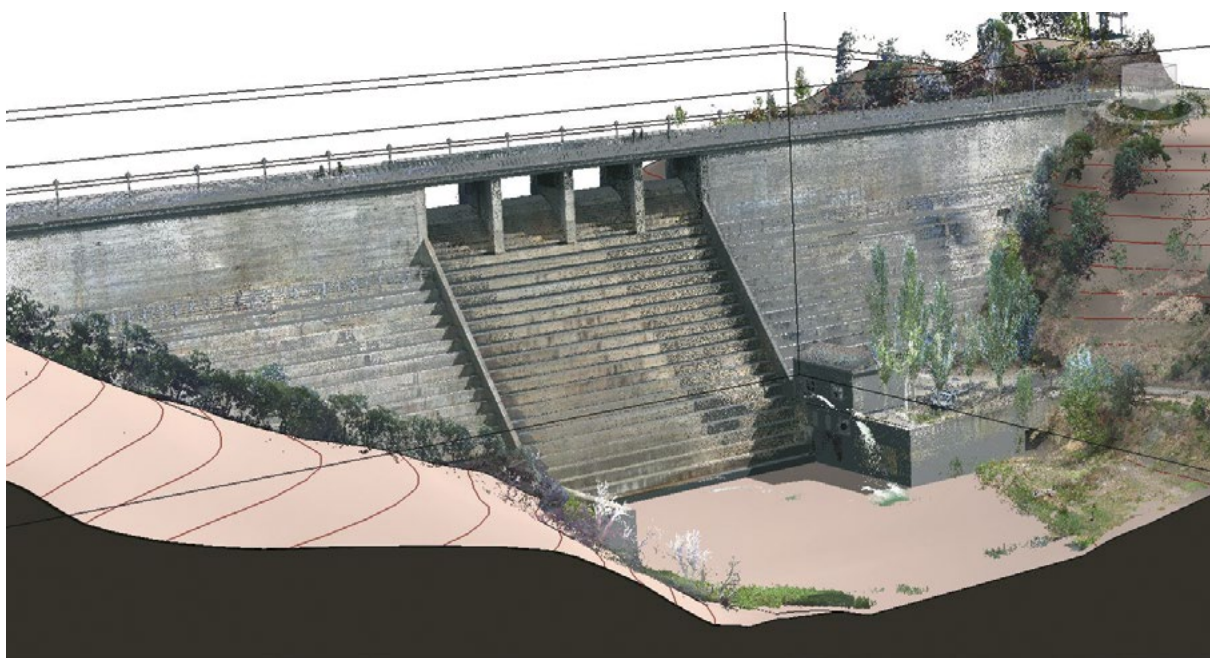
Vista general del modelo virtual, superponiendo la nube de puntos 3D y el modelo BIM.
