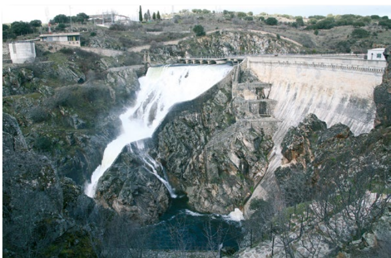
Aliviadero de la presa de El Villar.
