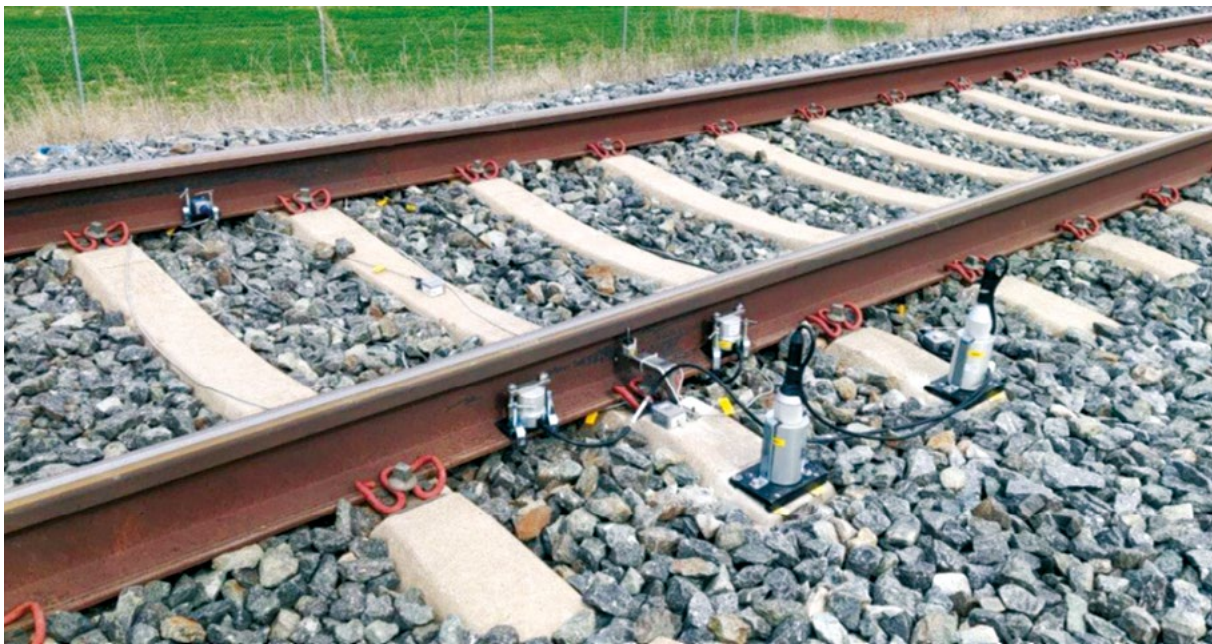
Figura 4. Vista de la instrumentación montada en una sección de la línea de alta velocidad Madrid-Barcelona.
