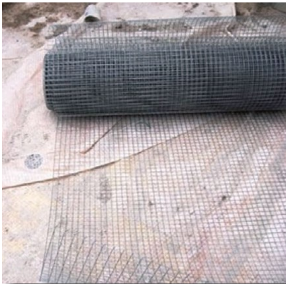
Armaduras de acero galvanizado y GFRP.
