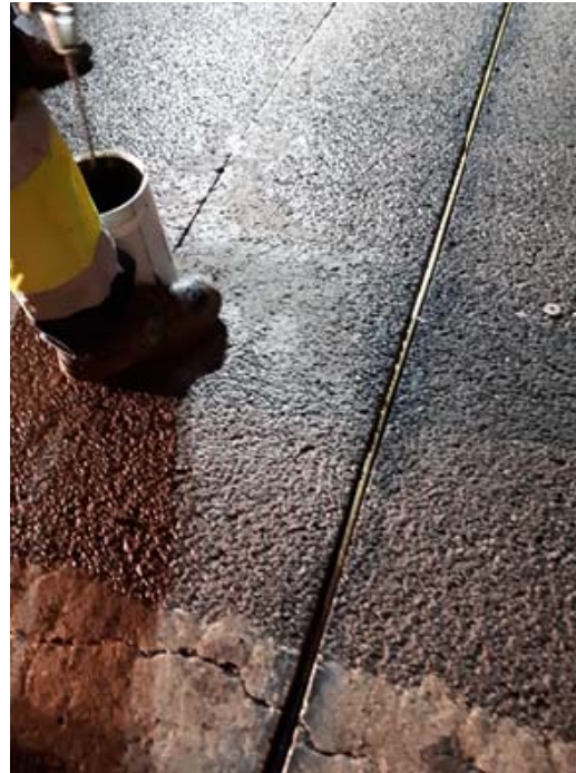
Colocación del sensor piezopolímero en la ranura
