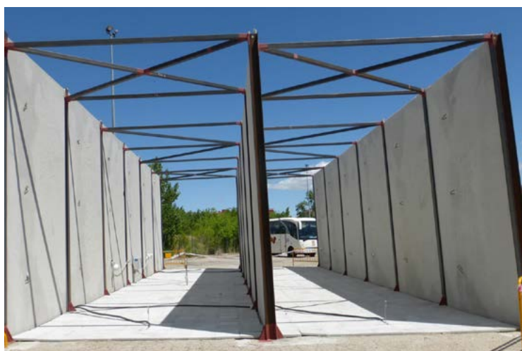
Proceso de construcción del doble "street canyon" para los escenarios de acera y fachada
