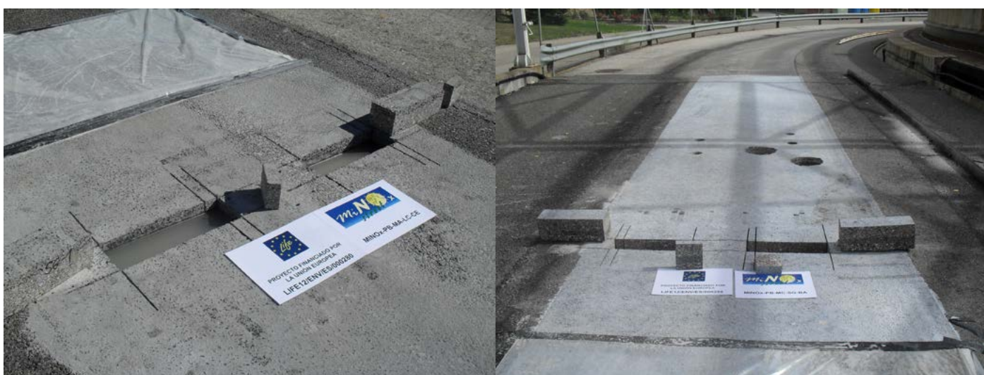
Extracción de muestras en secciones de la pista de ensayos del CEDEX
