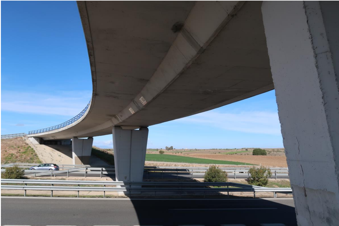
Ilustración 3.- Vista general del puente inspeccionado.
