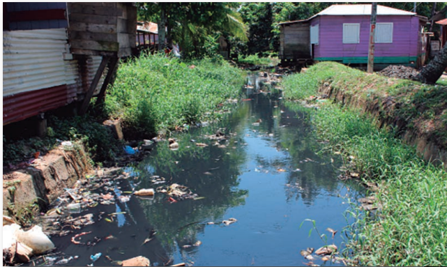
Open sewer (Nicaragua).
