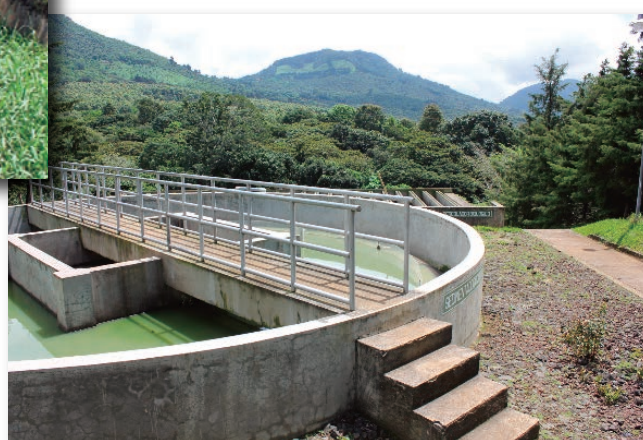
Planta de tratamiento de aguas residuales (El Salvador).
