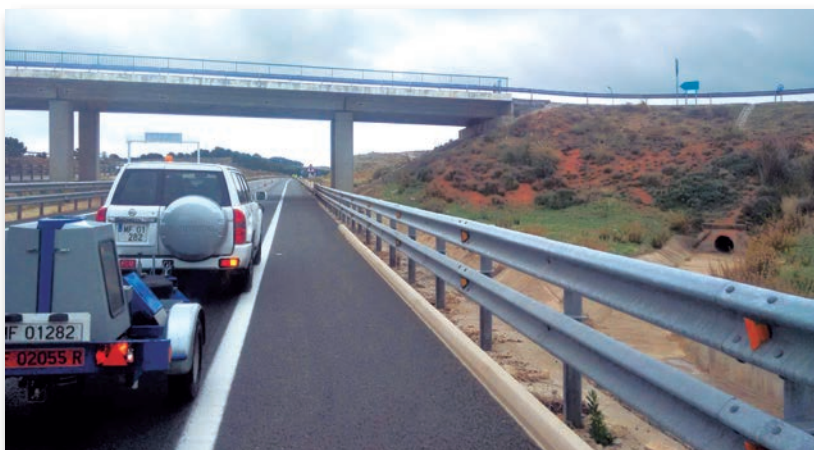
Equipo del CEDEX efectuando trabajos de comprobación del estado estructura de una carretera.
