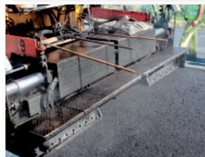
Extendido y compactación de mezclas asfálticas con polvo de caucho NFVU.
