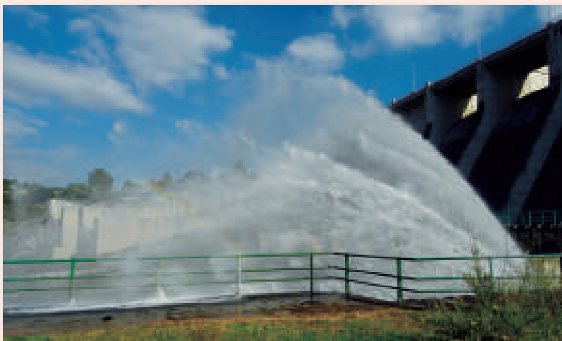
Desagüe de la válvula Howell en el embalse de Bellús.
