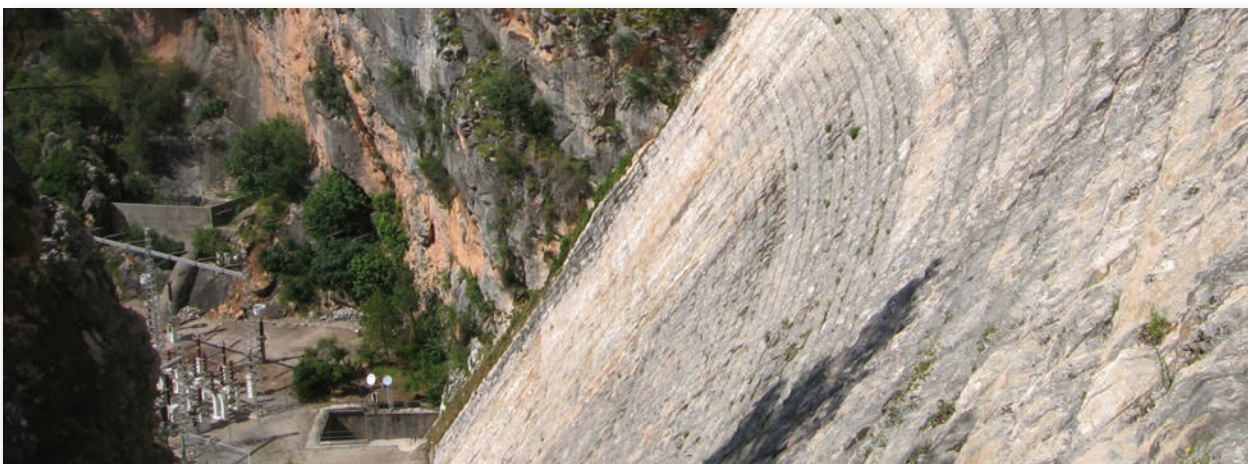
Paramento aguas abajo de la presa de Tranco de Beas.
