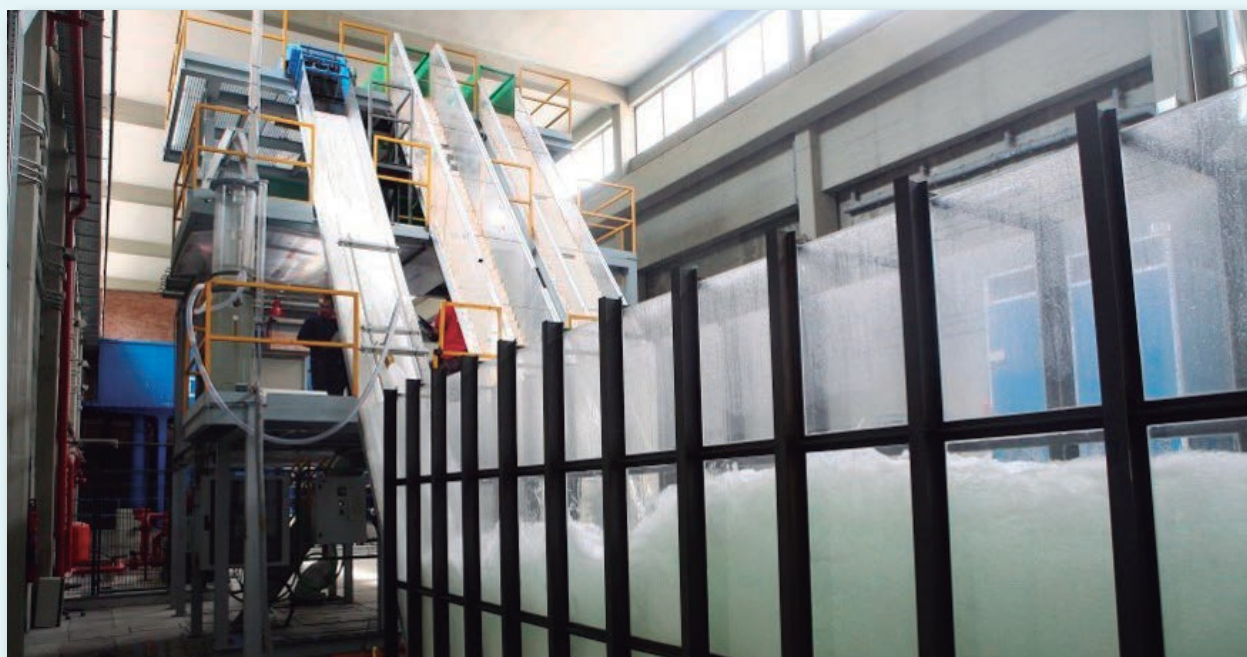
Instalación del proyecto EMULSIONA en el Laboratorio de Hidráulica.
