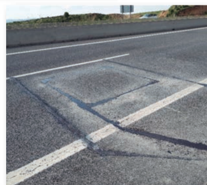
Aspecto final de los sensores de peso y el lazo de inducción una vez instalados en la calzada.
