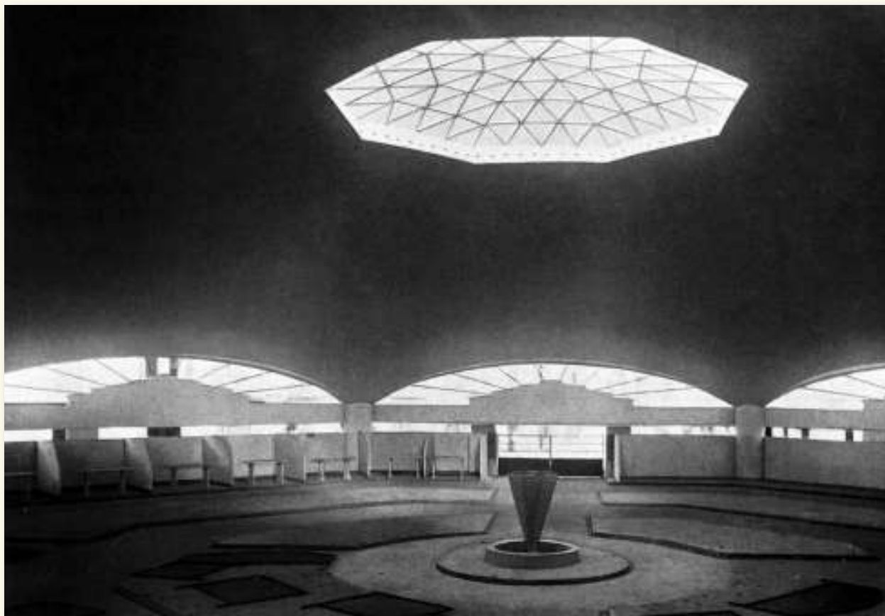
Imágenes del mercado de Algeciras, obra de Eduardo Torroja en la monografía E. Torroja. Sus Obras. 1926-1936 . Madrid, CEHOPU, 2019.
