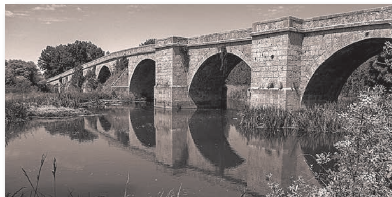
El puente de Ibero, también llamado Paso Ibero, Puente Fitero o Ponteroso, situado sobre el río Pisuerga entre Ibero de la Vega e Ibero del Castillo, es uno de los puentes más largos del Camino de Santiago, con once arcadas de sillería.
