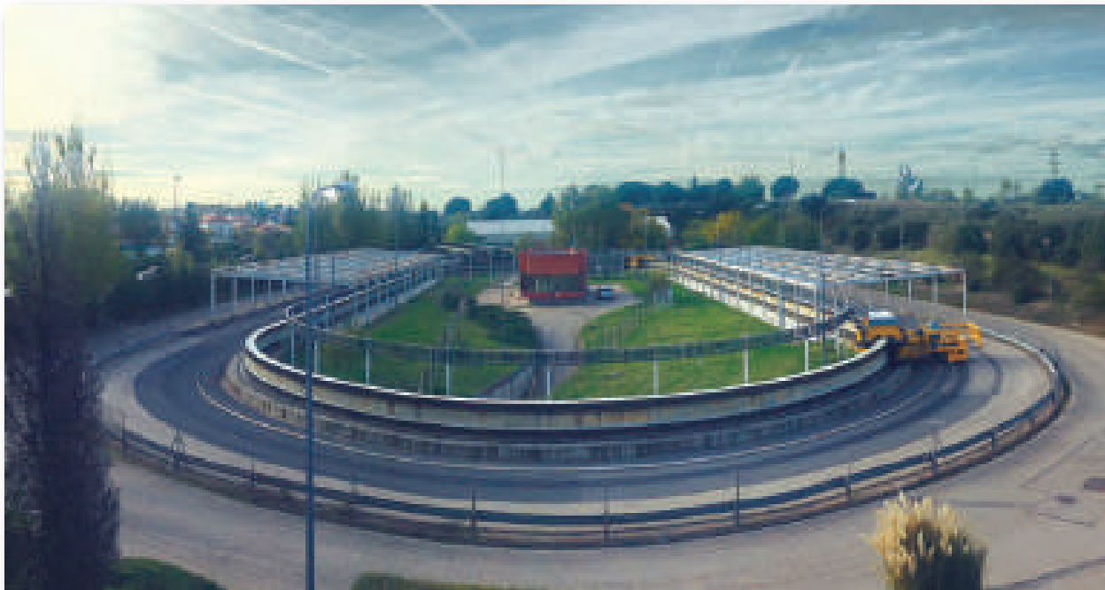
Vista general de la pista de ensayo de firmes a escala real.
